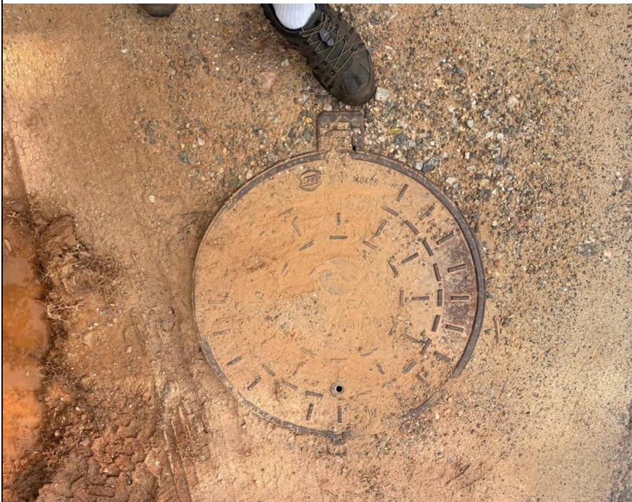
Figura 7 caixa de inspeção da rede coletora de esgoto, proximo ao terreno em estudo.
